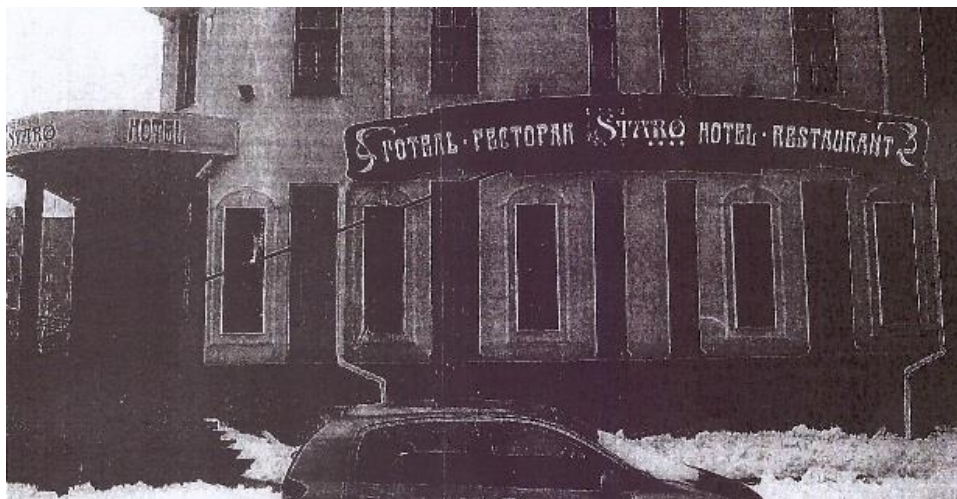
Фотокопія 1. Фасад готелю «Старо»
